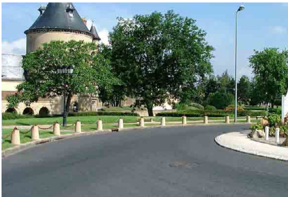
Photo 10 : Délimitant un rond-point, lieu fréquent de chutes à deux-roues motorisé, ces plots reliés entre eux par des chaînes peuvent causer des blessures supplémentaires au pilote d'un deux-roues à moteur en difficulté. Dans un tel cas, il est préférable de laisser les abords du rond-point vierge de tout mobilier urbain.
