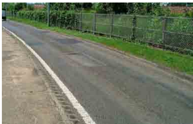
Photo 2 : Photo de gauche : située au milieu de la chaussée dans un virage ( peu visible et en pleine trajectoire), cette plaque d'égout métallique s'avère particulièrement dangereuse pour les motards, notamment en cas de chaussée humide ; le recours à une plaque recouverte de bitume (photo de droite), est dans ce cas une meilleure solution.
