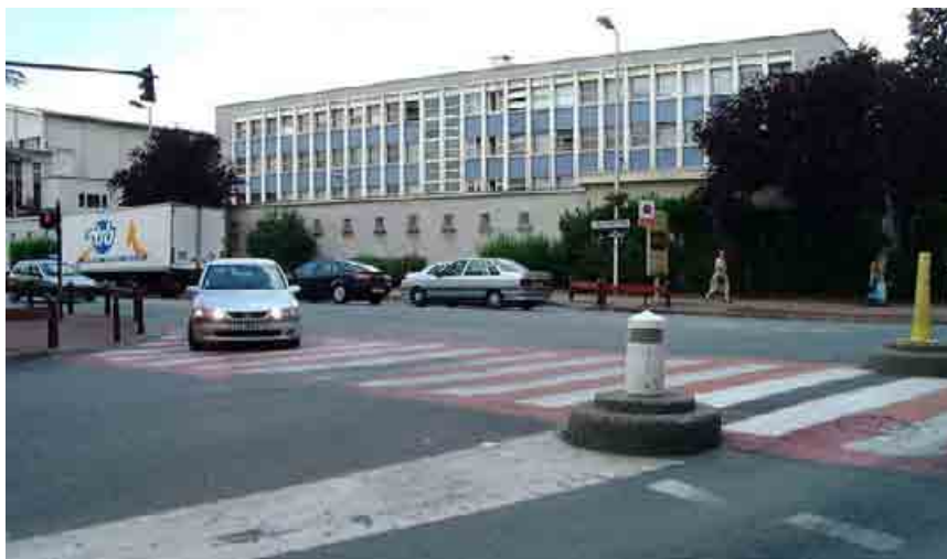
Photo 1 : Ce passage piéton est particulièrement mal adapté aux deux-roues car situé en plein virage pour les véhicules venant de l'autre voie et réalisé avec une peinture spécialement glissante en cas de pluie
