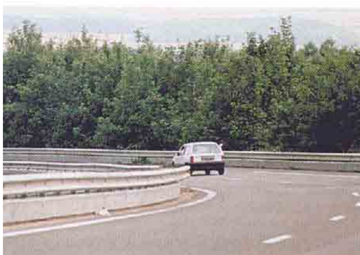
Photo 14 : L'écran standard en tôle plane, adaptable sur glissières existantes (photo SEC-ENVEL).
