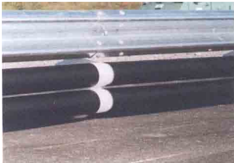
Photo 13 : L'écran MOTO.TUB, adaptable sur glissières existantes ; (photo SODIREL).
