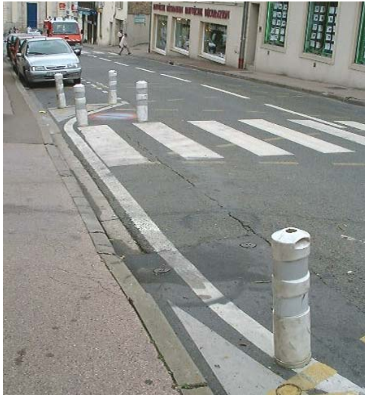
Photo 9 : Si leur esthétique reste discutable, ces équipements jouent pleinement leur rôle sans occasionner de blessures lors d'un choc avec un conducteur de deux-roues motorisé.
