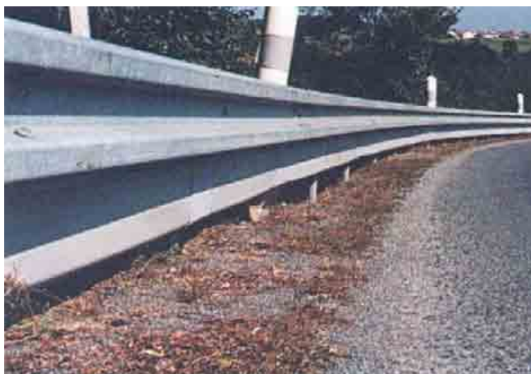
Photo 15 : L'écran RAILPLAST, adaptable sur glissières existantes (photo SODILOR).
