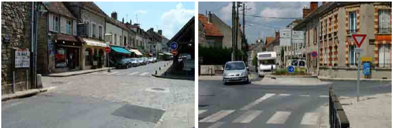
Photo 6 : Photo de gauche : ce type de carrefour aveugle (la partie droite de la chaussée est également bordée d'un mur masquant la route arrivant de la droite) à la signalisation sommaire n'est pas satisfaisant du point de vue de la sécurité. Un rond point offrant une bonne visibilité et une signalisation adaptée (photo de droite) permet, en atténuant les conflits, d'offrir une sécurité globalement satisfaisante.
