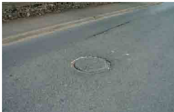
Photo 2 : Photo de gauche : située au milieu de la chaussée dans un virage ( peu visible et en pleine trajectoire), cette plaque d'égout métallique s'avère particulièrement dangereuse pour les motards, notamment en cas de chaussée humide ; le recours à une plaque recouverte de bitume (photo de droite), est dans ce cas une meilleure solution.
